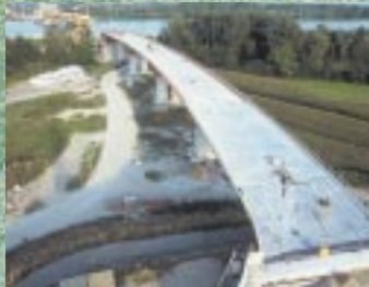
Le Pont sur le Rhin de gauche à droite : Tablier - Viaduc côté français - Pieux de \varnothing 180 des piles
